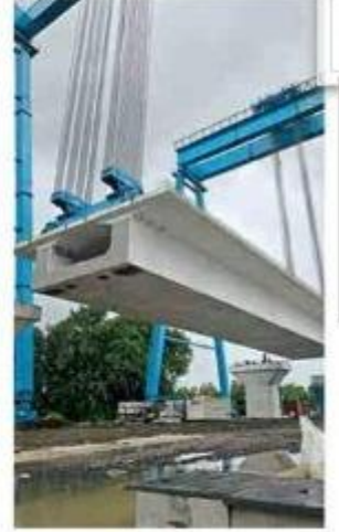
बुलेट ट्रेन प्रकल्पात गर्डर बसविला.
